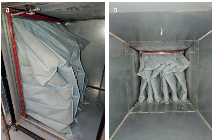
Rys. 3. Kieszeniowy filtr powietrza – powierzchnia boczna (a) i filtracji (b)
